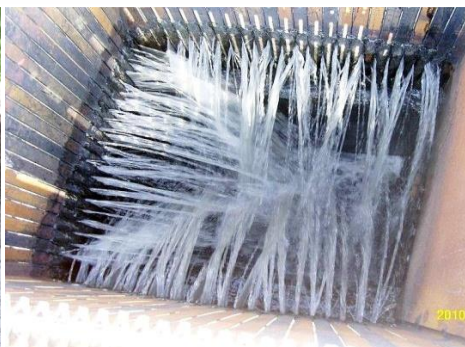
Отведение воды через специальный колодец
