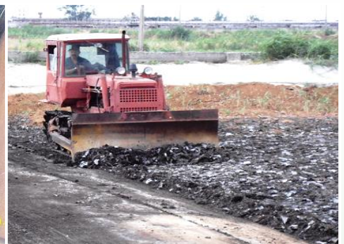
Выгрузка обезвоженного ОСВ Влажность менее 70%.
